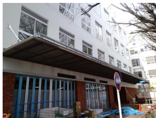
図 2-12 建設中の南4号館
