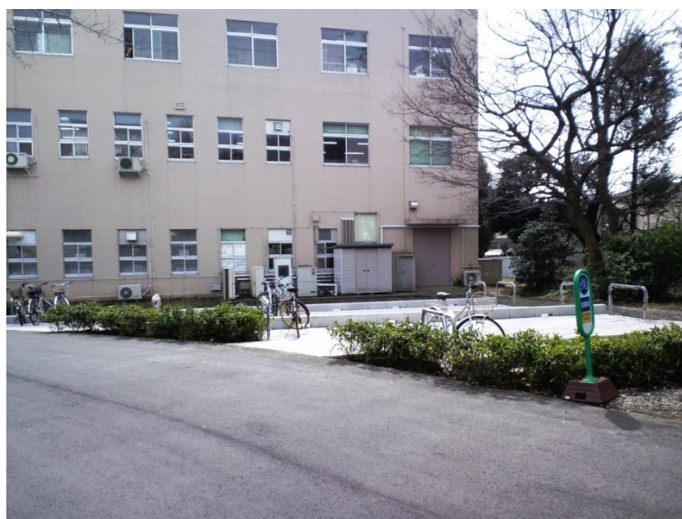
図 2-13 石川台地区駐輪場
